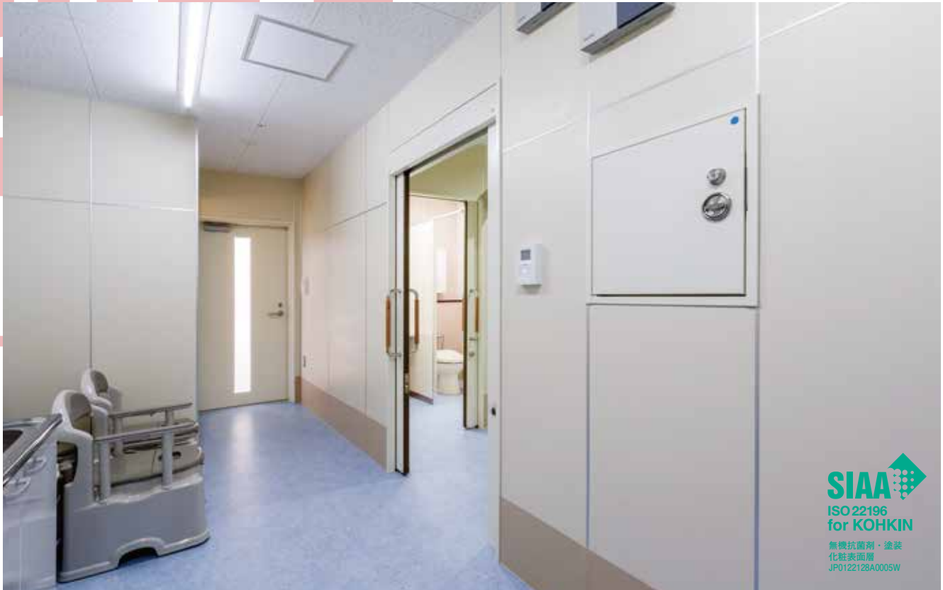
富士いきいき病院 内壁 スタンド#400
