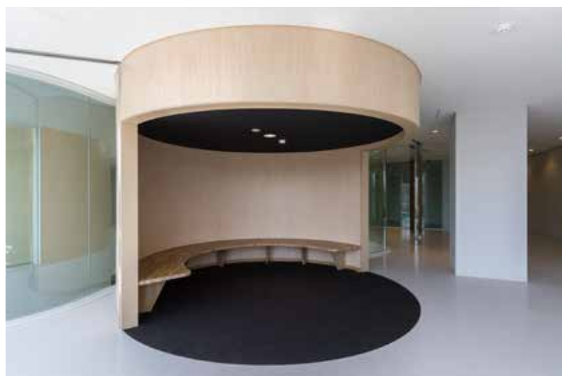
北海道大学 フード&メディカルイノベーション国際拠点 内壁(曲面) エフジーボード
