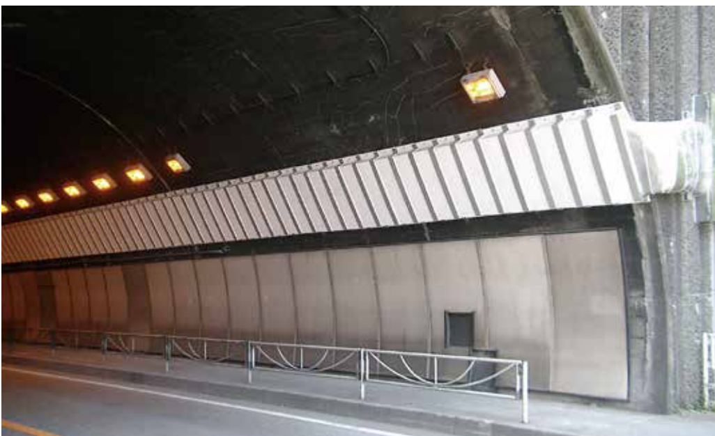
南部トンネル トンネライト吸熱パック工法
