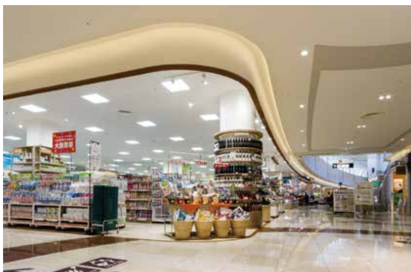
アリオ市原 曲面垂れ壁 エフジーボード
