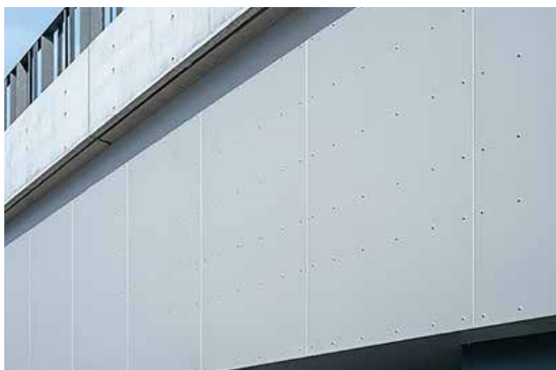
サッカースタジアム 外壁(現場塗装) セルフレックス
