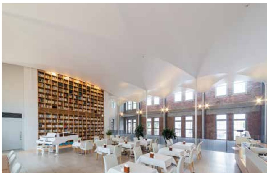
北菓楼札幌本館 曲面天井 エフジーボード
