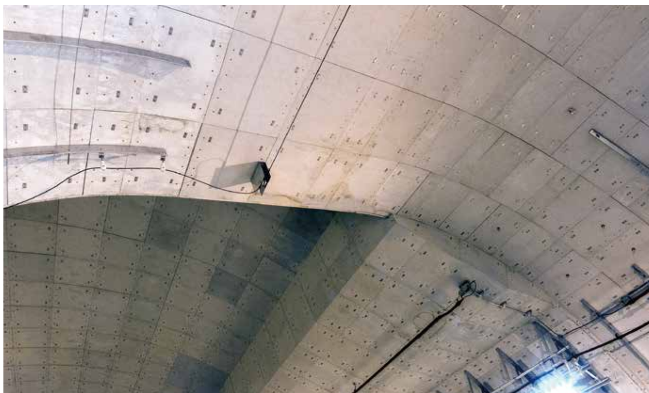
トンネライト施工状況
