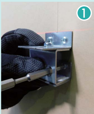
壁下地に対し廊下用支持金具をビス固定
