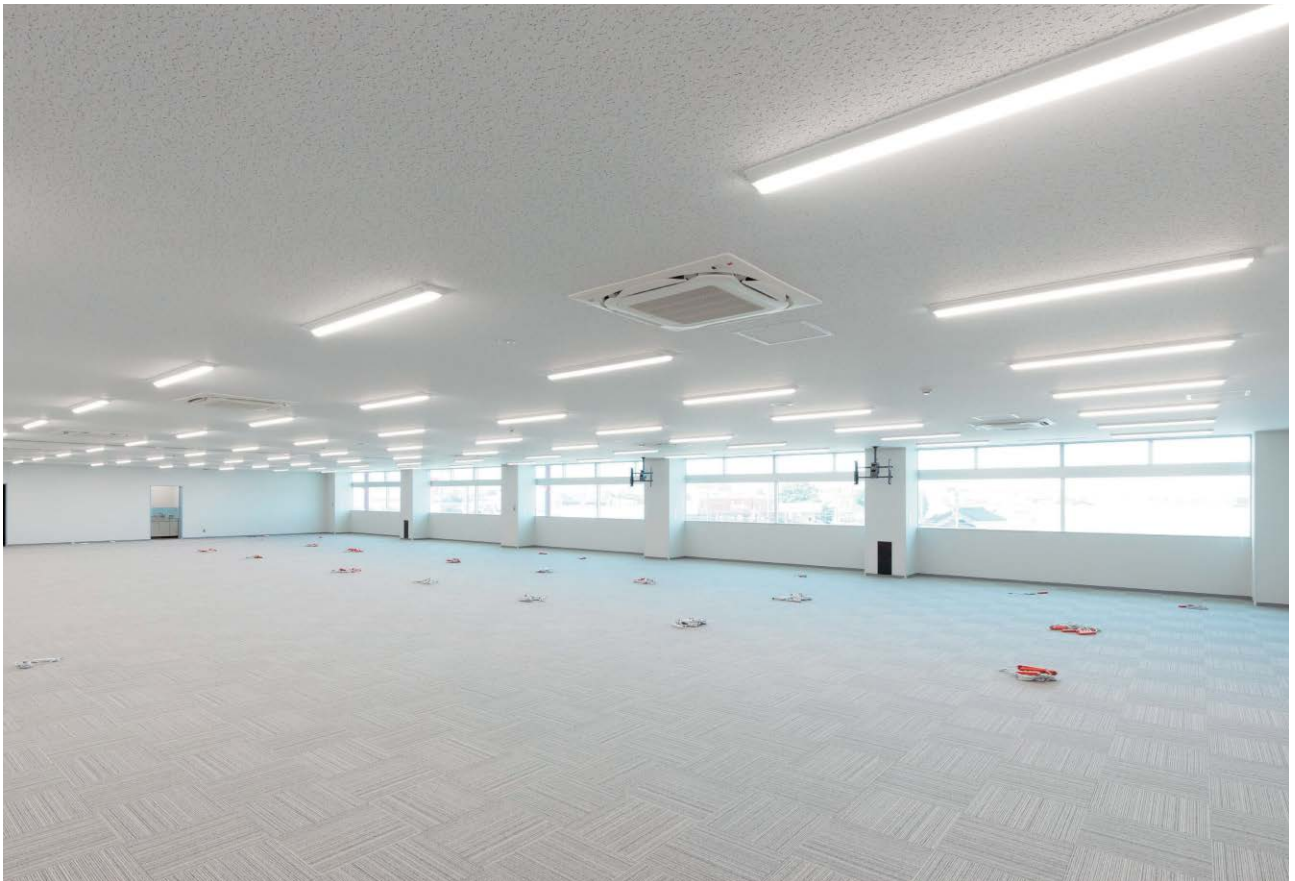
魚津電気ビル(富山) (ダイケンハイブリッド天井 採用物件)
