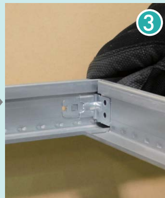
廊下幅に対応する長さのDHクロスをDHメインに差し込む
