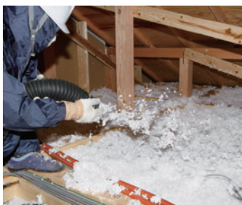
天井点検口などから入って施工
