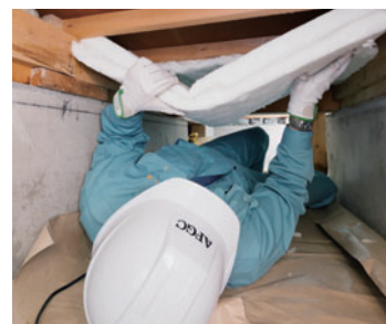
床下収納庫などから床下にもぐって施工
