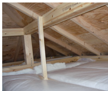
天井点検口などから入って施工
