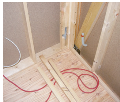
根太床 (根太が土台・大引と平行している場合)
