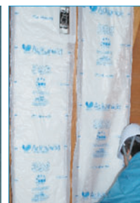
防湿フィルムを戻しタッカー針で留めます。
