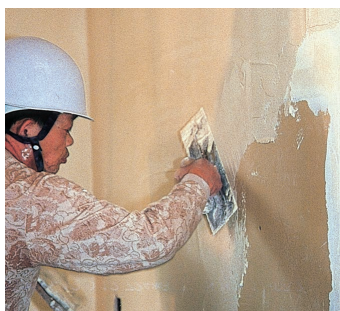
タイガーケンコート直仕上げ施工
