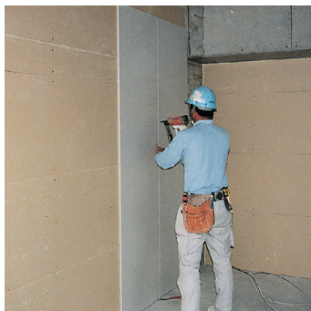
堅牢性に優れた「タイガースーパーハード」(写真は鋼製の耐火遮音壁「A-2000・WI」によるマンションの戸境壁)
