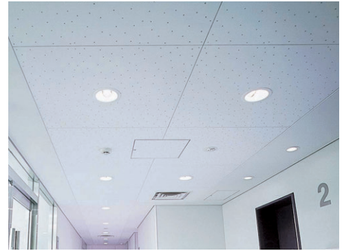
ステラート・ライトによる施工
