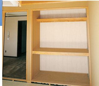
タイガーハイクリンスカット押入ボード 施工中の一例
