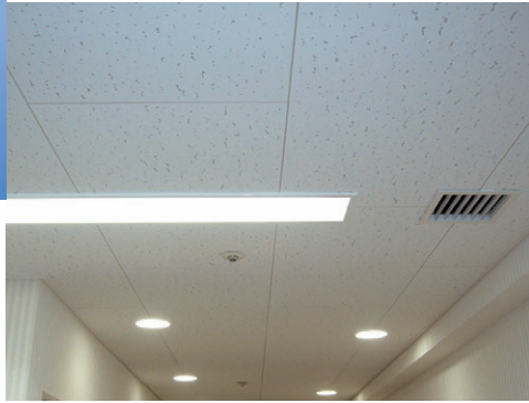
ジブトーン・ライトによる施工
