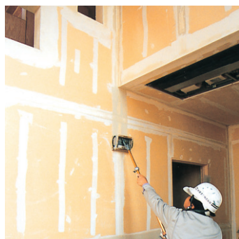
ドライウォール工法で施工中の一例
