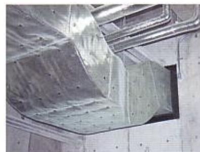
▲ ダクト遮音工事サンドムLA10
