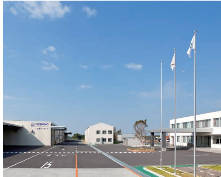
日本ソーラトン(株)工場
